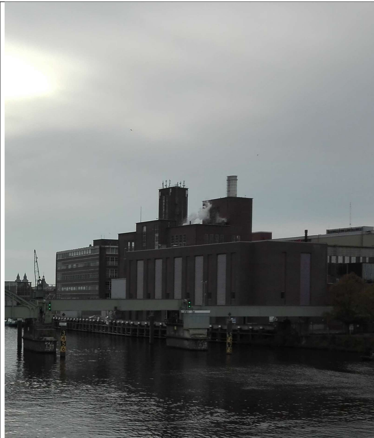
Sappi-Noord Maasfront, vanaf de Noordbrug, zicht op de gevel van 1989 en de centrale -in baksteen. Te behouden, omdat de gebouwen vormen karakteristiek ensemble. Het zijn industriële gebouwen met een architectonische kwaliteit. Daarnaast het kantoorgebouw (mogelijk te behouden).
