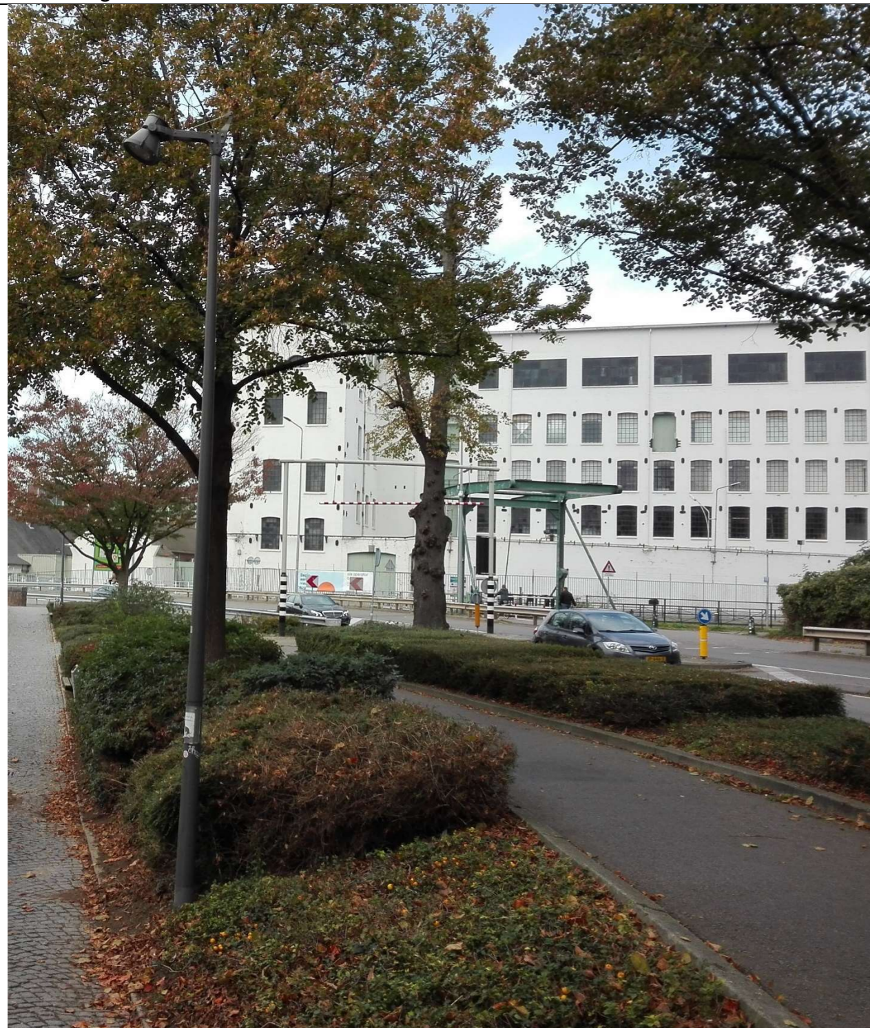
De papierfabriek van 1859, Biesenweg 16, rijksmonument, met sluis gezien vanaf het Bassin. Te behouden industrieel erfgoed.
