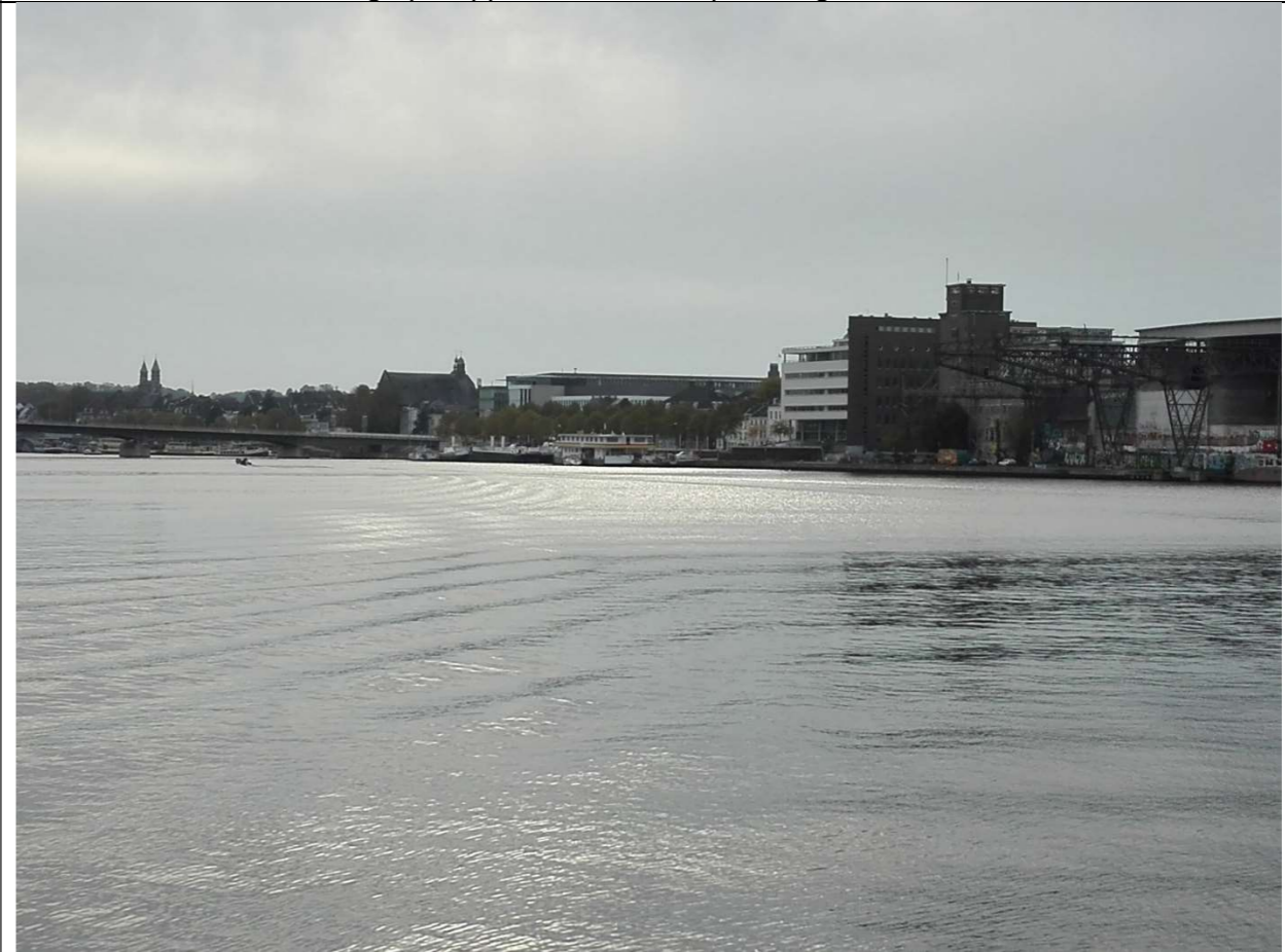
Zicht vanaf de Griend op het Landbouwbelang, en de rest van het Maasfront tot aan de Wilhelminabrug
